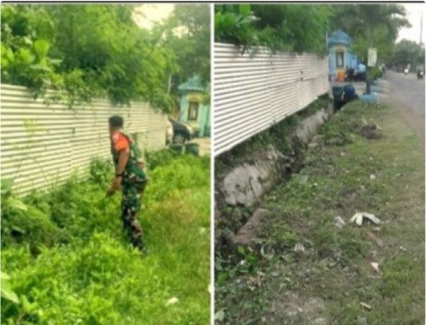
Sebelum pembersihan dan setelah pembersihan
