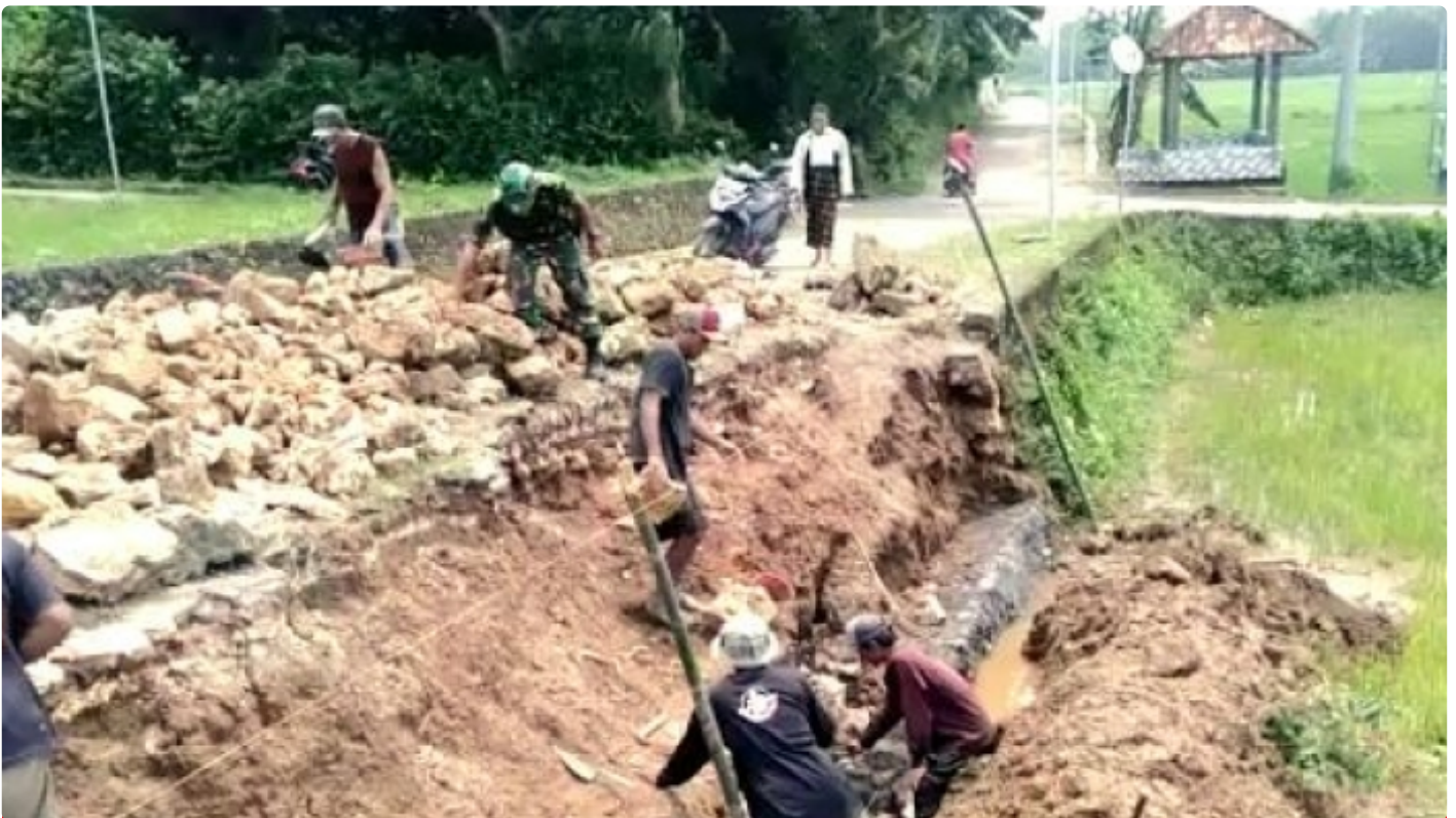
Karya Bakti pembuatan plengsengan penahan jalan
